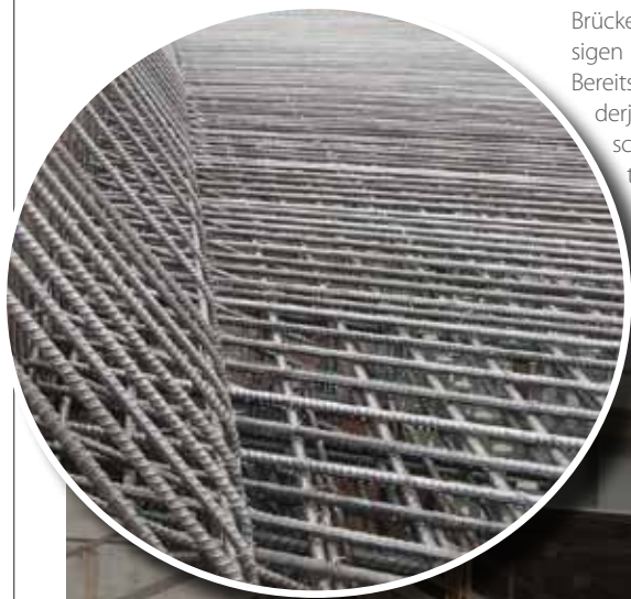
△ Bewehrung aus Edelstahl Rostfrei in den neuen Fahrbahnen (vor dem Betongießen)
