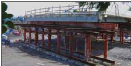
△ Neue Brückenabschnitte auf Stützstrukturen im Bereitstellungsbereich
