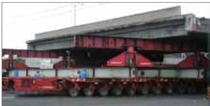
△ Ein Transporter fährt den alten Brückenabschnitt weg
