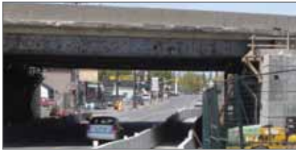
△ Ursprüngliche Brücke vor der Erneuerung
