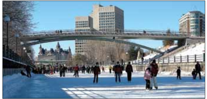
△ Die Corktown Footbridge (Fußgängerbrücke) über den Rideau-Kanal
